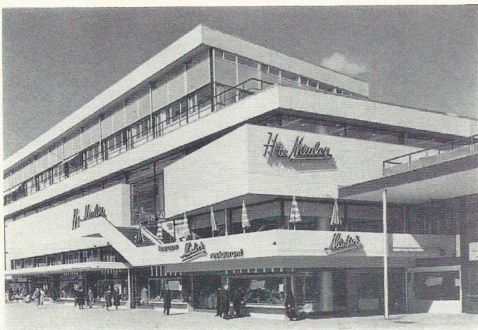
15. Van den Broek & Bakema, Winkelgebouwen Ter Meulen, Rotterdam, 1950 (from Nederlandse Architectuur [Argus, Amsterdam, 1956]).
